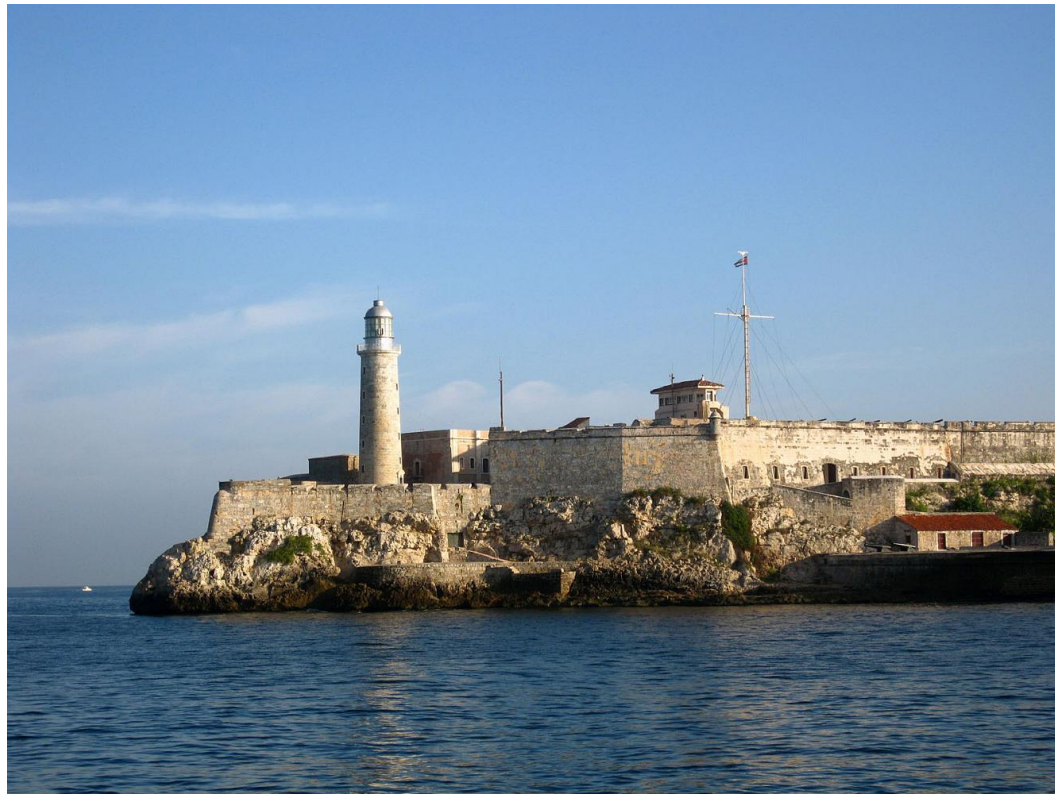
Castillo de San Sebastián en Cádiz, construido en el siglo XVIII, y Castillo de los Tres Reyes Magos del Morro en La Habana, terminado en 1610 y reconstruido a partir de la toma de los ingleses en 1762. El faro sustituyó a la torre anterior, de acuerdo con la tradición establecida en Cádiz en 1795.
