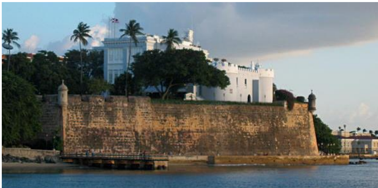
Frentes marítimos amurallados de Cádiz y de San Juan de Puerto Rico
